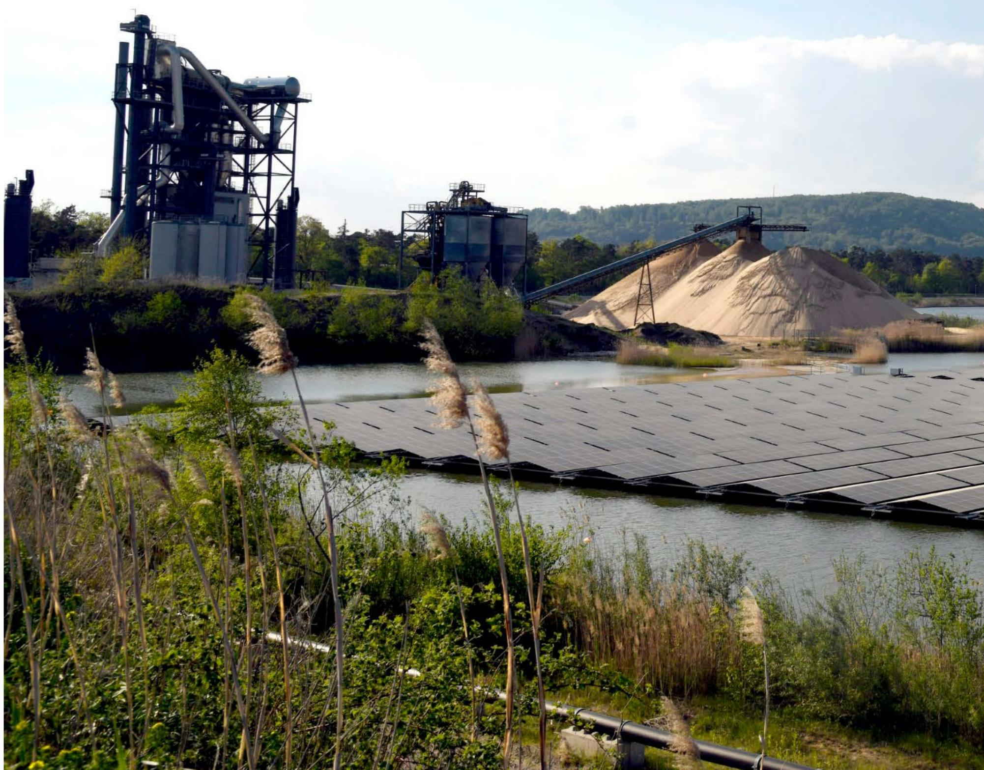
**D**ie Firmengruppe Max Bögl aus Neumarkt hat auf einem Baggersee in der firmeneigenen Sandabbaugrube in Sengenthal 2022 eine Floating Photovoltaikanlage errichtet, die zu den größten ihrer Art in Deutschland gehört. Bei einer Floating Photovoltaikanlage werden die Solarmodule auf einer schwimmenden Unterkonstruktion montiert. Die Anlage soll pro Jahr mehr als 1,6 Mio. KWh umweltfreundlichen, regenerativen Strom erzeugen, der dann direkt vor Ort genutzt werden kann.
