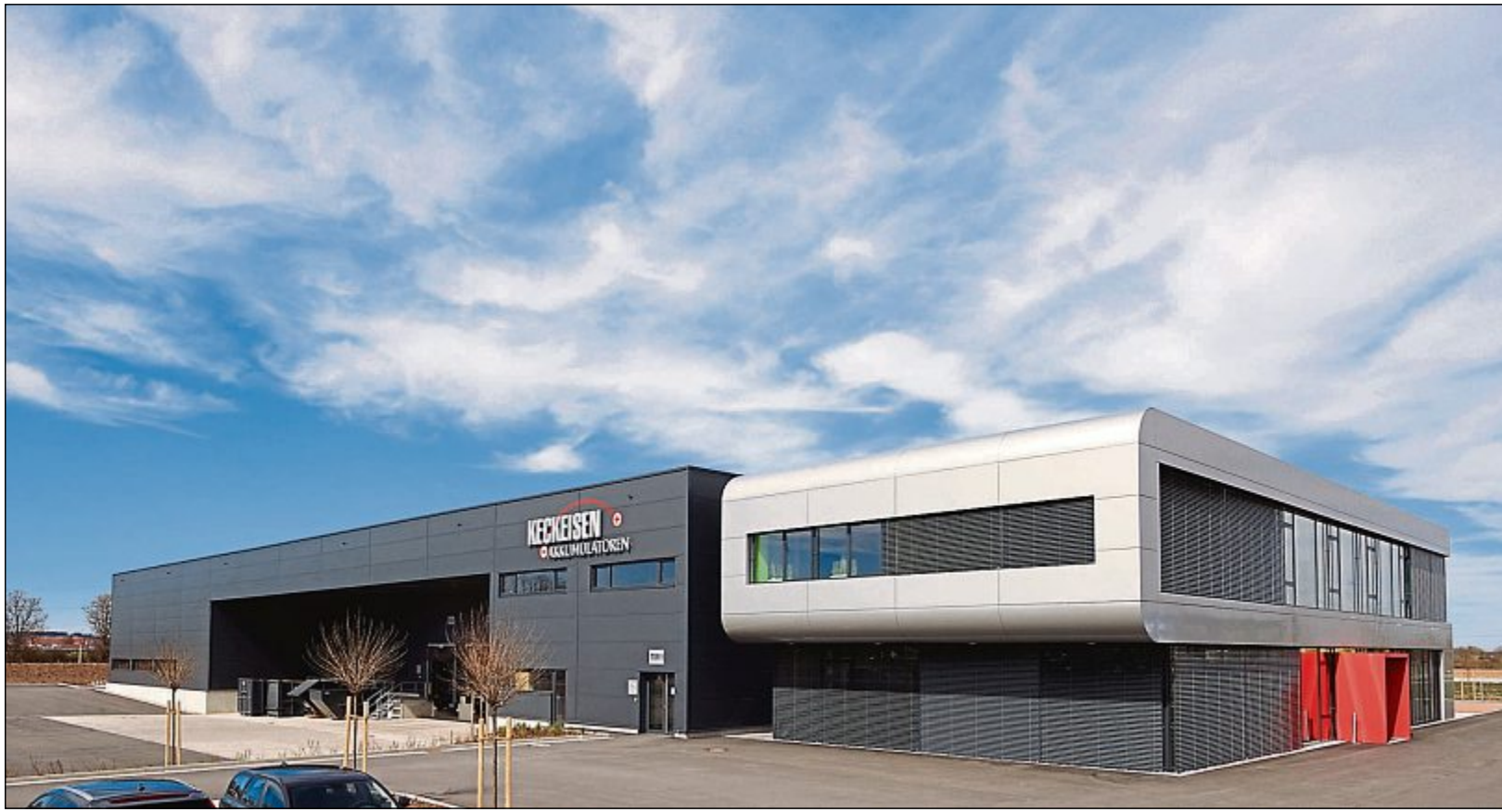
Hier wird mit Grundwasser geheizt und gekühlt.
