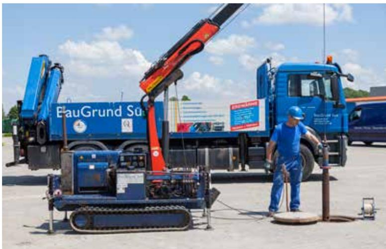
*Kolbgerät: Der Kolben wird im Brunnenrohr auf- und abgefahren. Dabei werden Ablagerungen aus dem Ringraum in den Brunneninnenraum gesogen und können mittels Pumpen entfernt werden*
