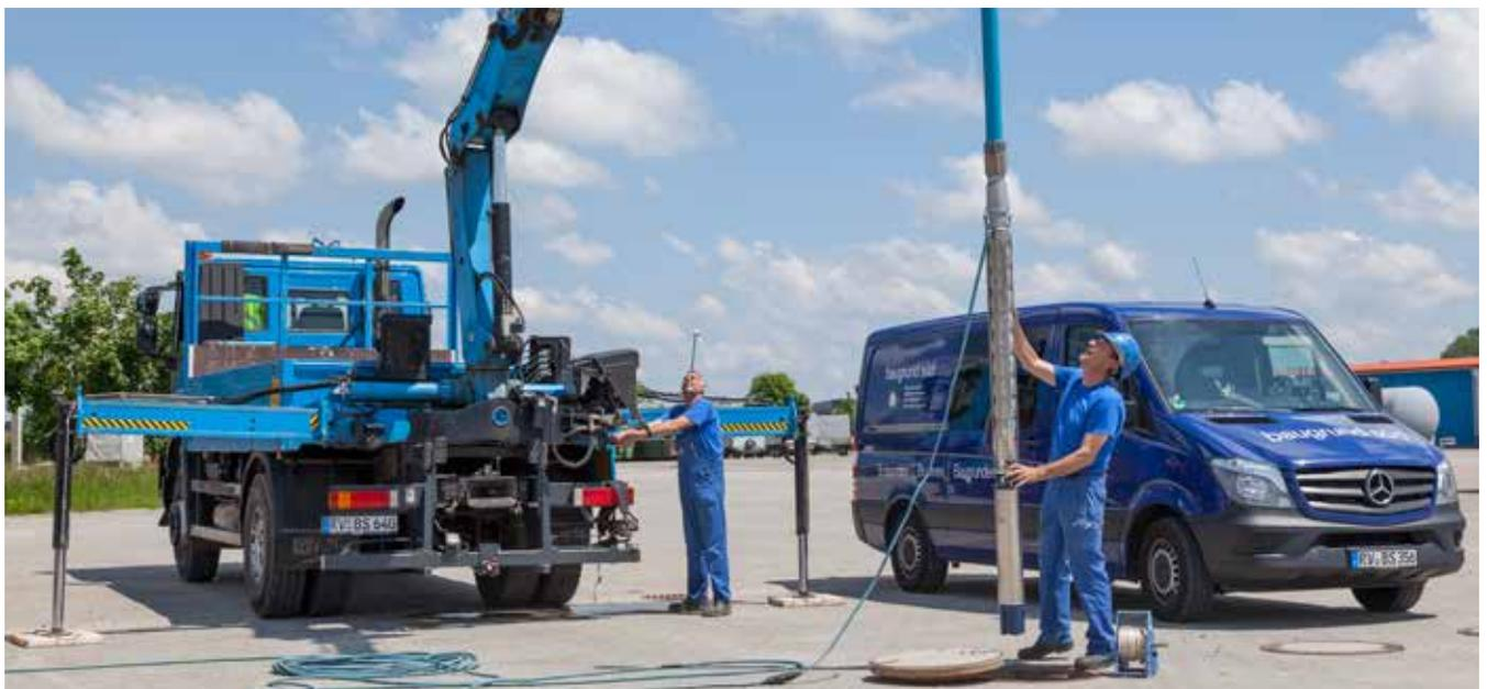
*Überprüfung Brunnenpumpe (Ziehen der Unterwasserpumpe)*
