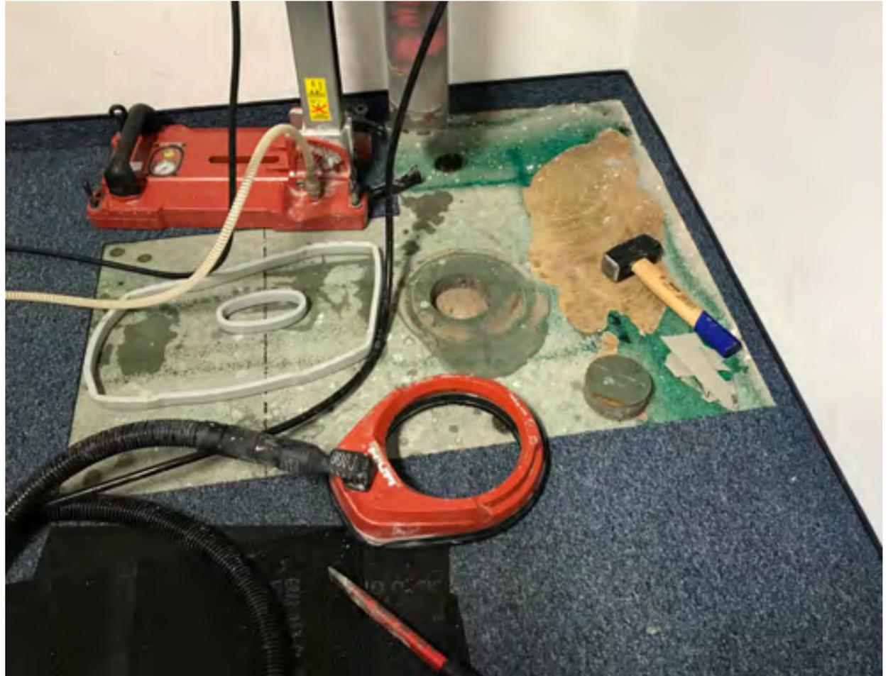
Entnahmestelle des Bohrkernes samt Gerätschaften für die Entnahme.
