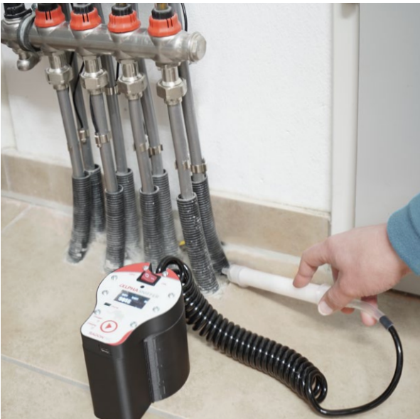
Aktive Messung mit Radon Sniffer im Zuge einer Objektbegehung.
