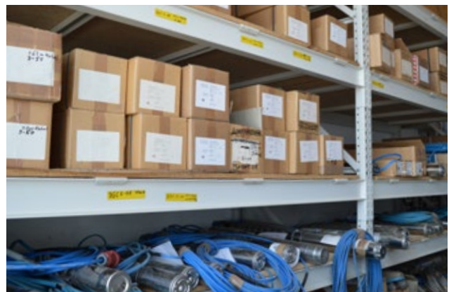
Schnelle Reaktion durch eigenes Pumpenlager
